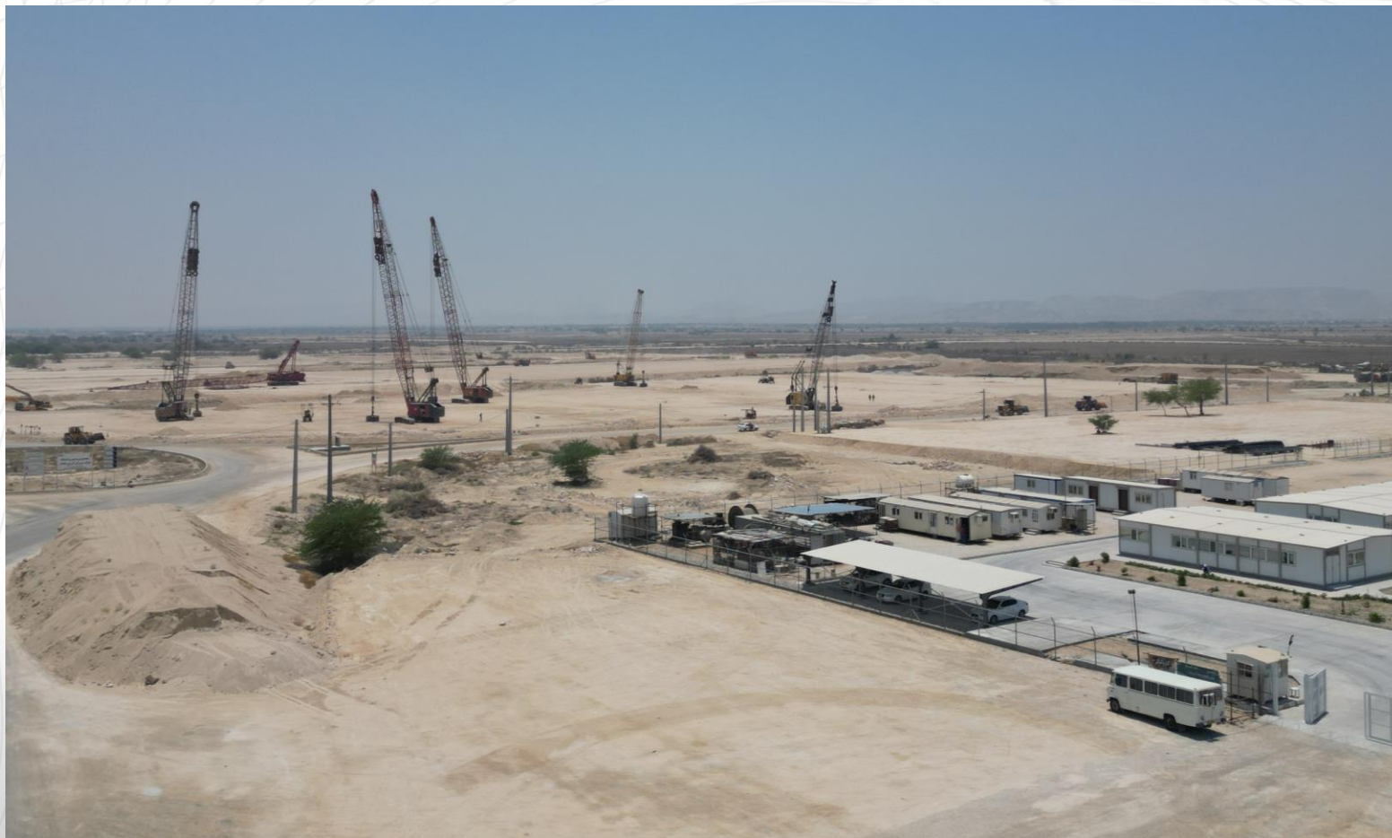
عملیات آماده سازی و تحکیم بستر زمین پروژه (شرکت عمران کیسون) عملیات احداث فنس پیرامون زمین پروژه (شرکت پترو آریائیان آپادانا)
