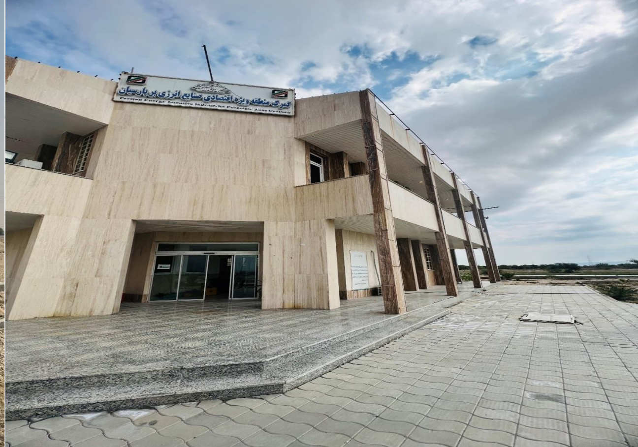
ساختمان اصلی اداری گمرک (سایت شمالی)
