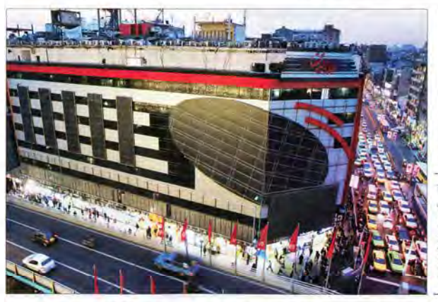
فرمانداری، مانع تخریب طبقه غیر مجاز علاءالدین شد
