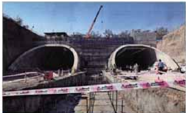
توتل حکیم در آستانه بهره برداری | پروژه ساخت تونل حکیم ۸۰ متری به زودت با شتاب است
